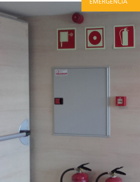
Señalización de EMERGENCIA
